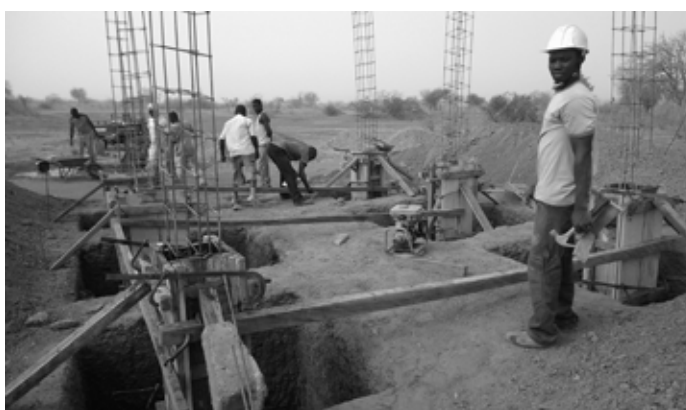
Die Betonstützen wurden gegossen – März 2015
